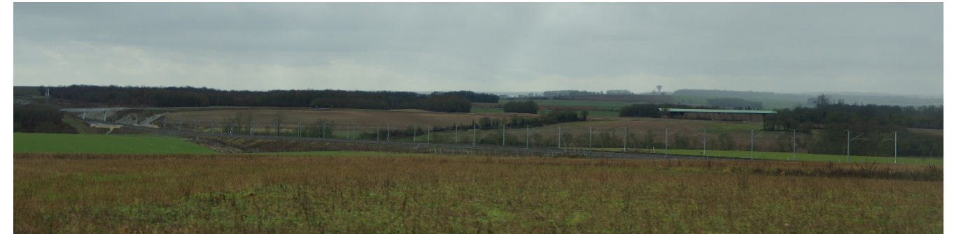
La voie ferrée, exceptionnellement visible au niveau du passage de la D27 en surplomb de celle-ci
